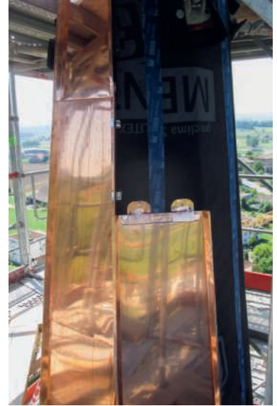
Neue Blecheindeckung beim Turmhelm.
