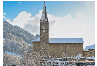
Die Kirche in Troistorrents wurde 1722 erbaut. Nun müssen Mauern und Gewölbe saniert werden. Bild: zVg
